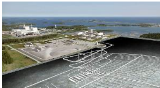
Slutförvaret för använt kärnbränsle
